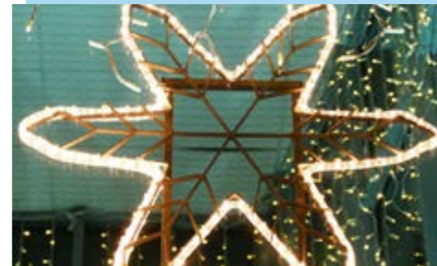
Pose des décors lumineux dans les rues de la commune
