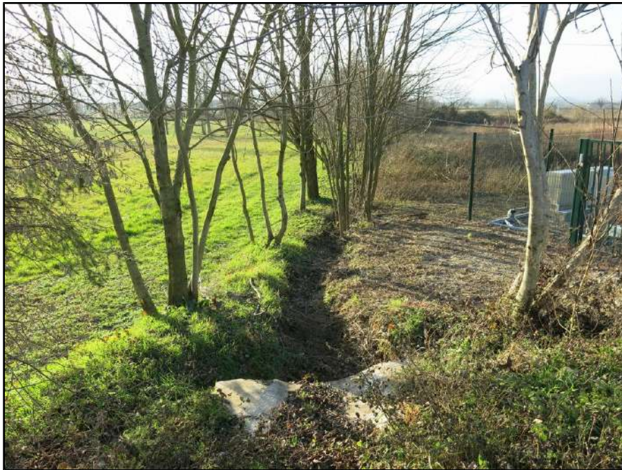
Figure 13: Le fossé d'évacuation des eaux collectées par le fossé de la RD102. Noter le poste de relevage en rive droite.
