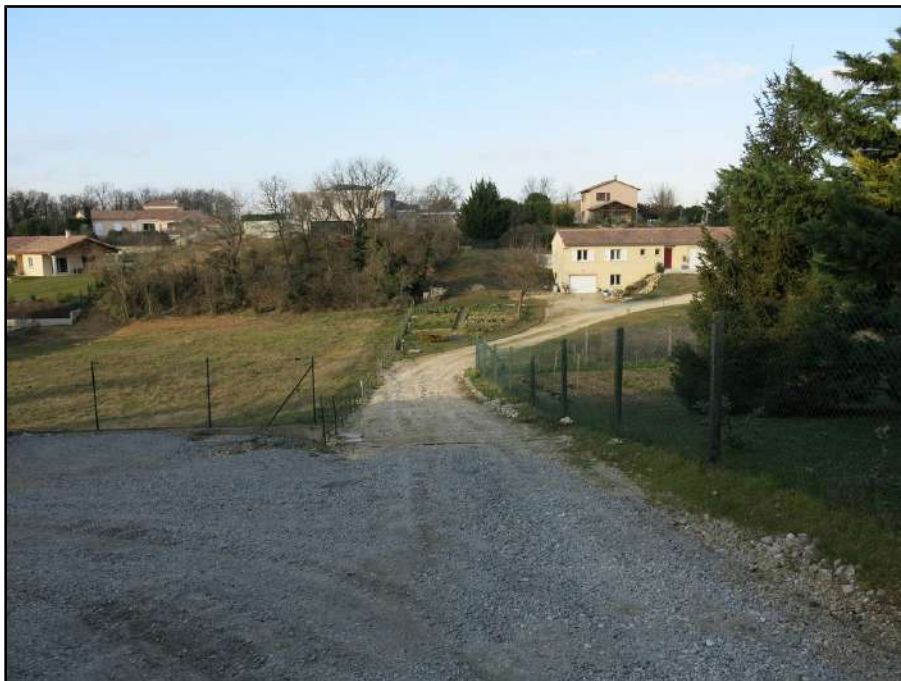
Figure 5: Accès privé à la parcelle n°437 traversant la combe de Carcaille. L'axe d'écoulement franchit cet accès au point bas.
