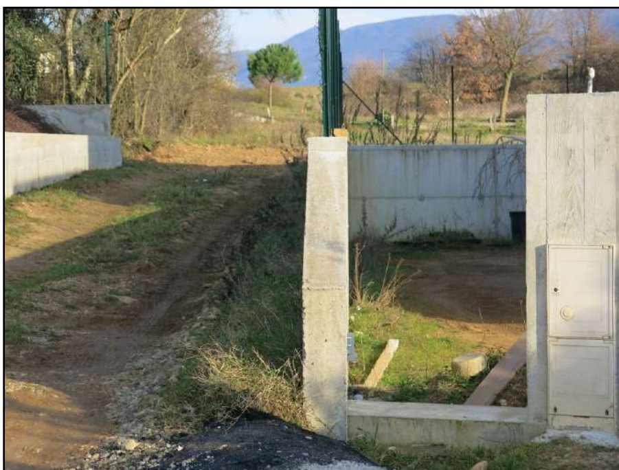
Figure 7: Extrémité amont du chemin du Petit Bois. La différence de niveau entre le chemin et la parcelle 407 (à droite) est bien visible.
